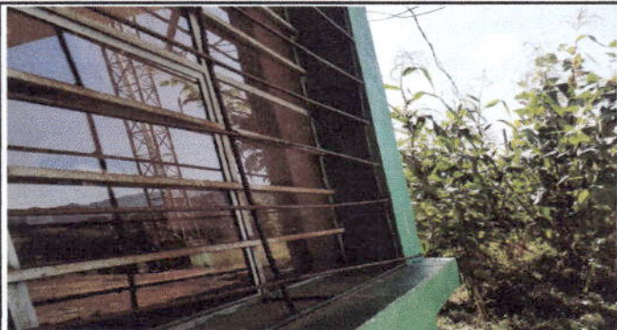
Foto 4: Se sustituirá el balcon de las ventanas por el deterioro del material.
